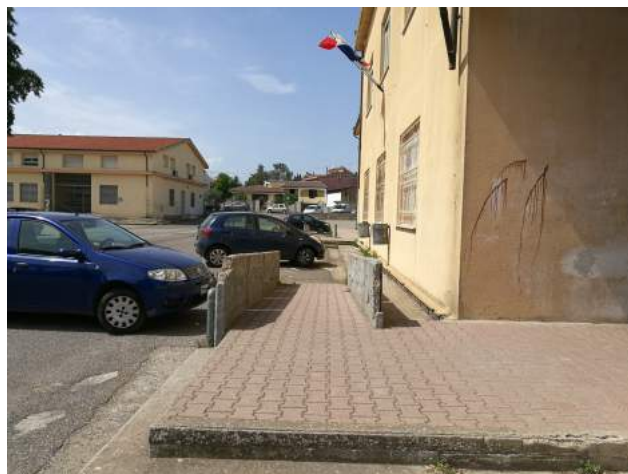
Percorso pedonale utilizzando le rampe esistenti
