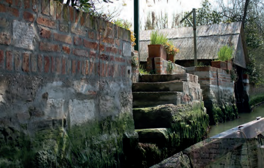
Riva di età contemporanea, con materiali architettonici di riuso
