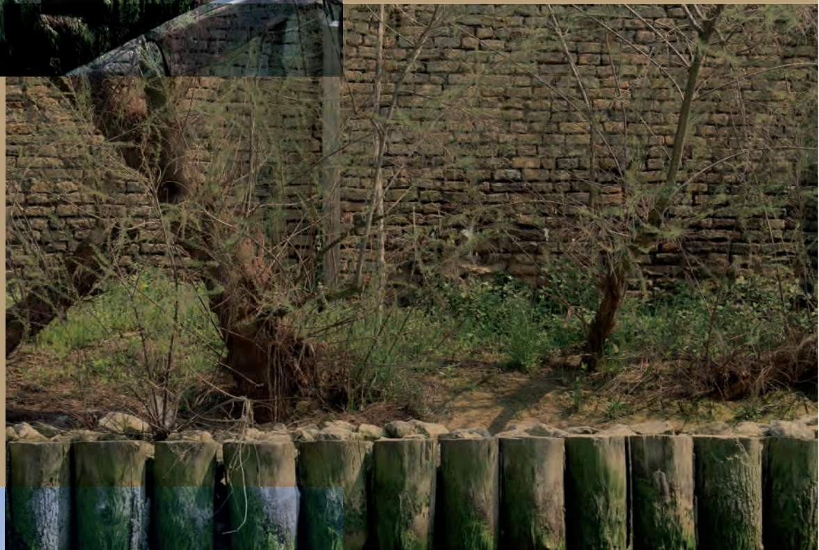
Muro medievale del Monastero di San Giovanni e riva contemporanea in pali di legno
